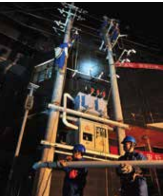
凯里供电局深夜检修，不影响客户正常用电 ▲
