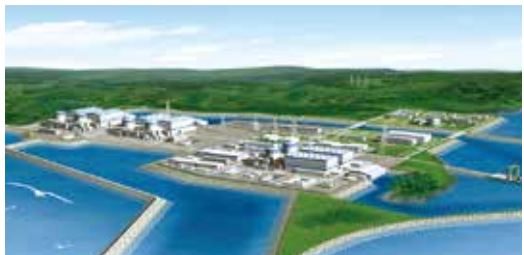
2013年3月，500千伏广西防城港核电站送出工程开工建设
