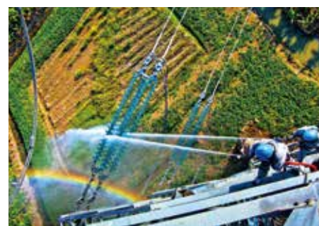
高空冲洗电力设备 ▲
